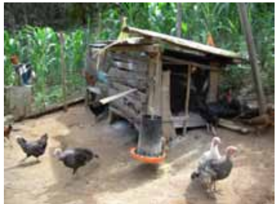
4. Instalaciones para aves construidas con recursos locales
